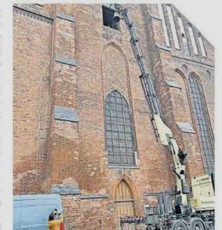
Mit einem Kran wird die Glocke durchs Kirchenfenster gehoben. Pastorin Antje Exner fotografiert das Ereignis.
